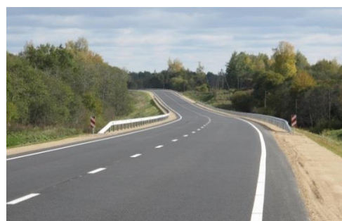
Att.Nr.9. Autoceļa E22 posms Ludza – Terehova pēc Rekonstrukcijas Datu avots – VAS “Latvijas valsts ceļi”
