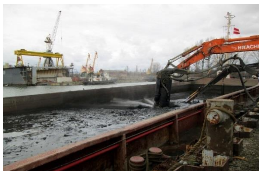
Att. Nr.1. Projekts Nr. DP/3.3.1.6.0/14/IPIA/VARAM/001 "Vēsturiski piesārņotas vietas Liepājas ostas Karostas kanāla attīrīšana, I kārtā". Datu avots: http://www.lsm.lv
